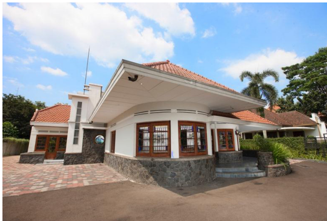
Gambar 10. The Van Hoeis (Sumber: dokumentasi penulis)
