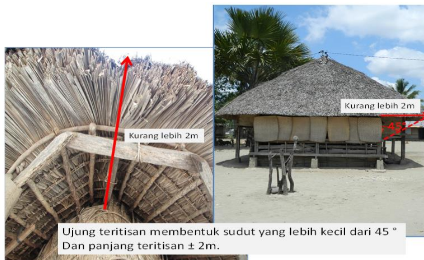
Gambar 4. Penciptaan bentuk atap uma yang tanggap terhadap iklim (Sumber: (Laboratorium Arsitektur Vernakular, 2012)
