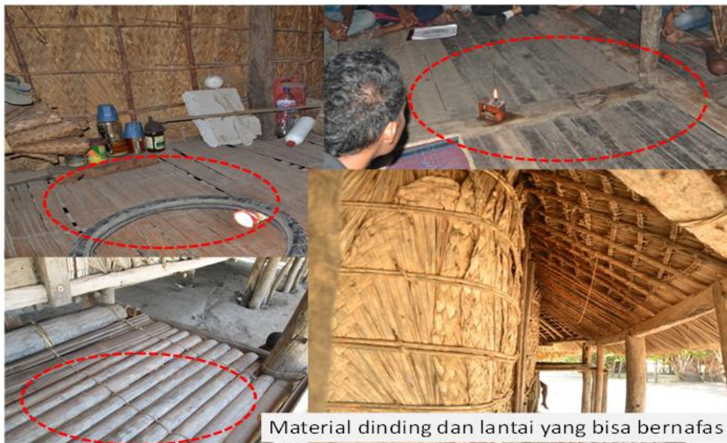
Gambar 6. Dinding dan lantai uma terbuat dari material lokal Sumber: (Laboratorium Arsitektur Vernakular, 2012)
