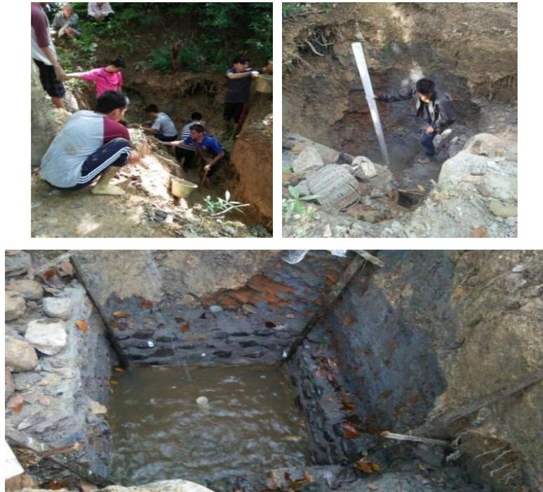
Gambar 5. Pembuatan Bak Penampungan Air
