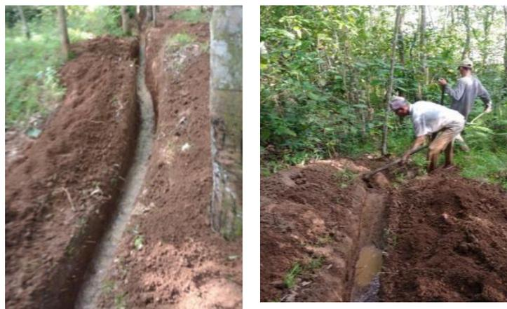
Gambar 6. Pembuatan Saluran Air dari Bak
