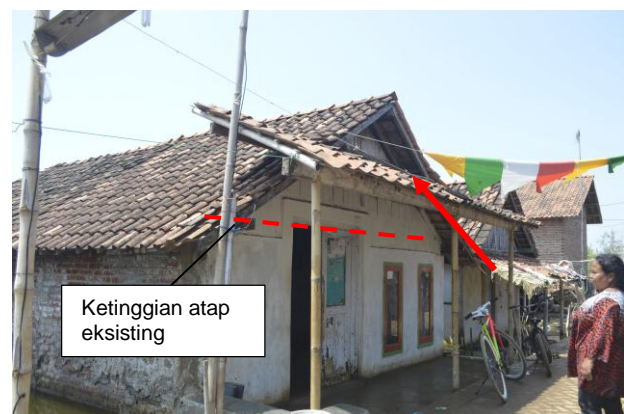
Gambar 12. Peninggian atap teras rumah warga RT005-RW004
