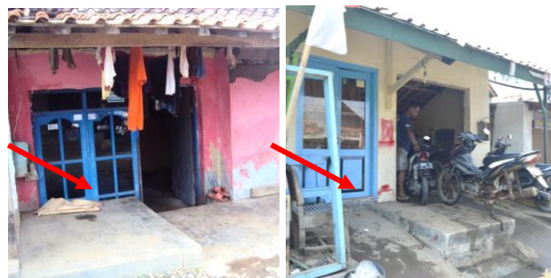
Gambar 8. a. peninggian lantai teras Tipe 1, b. peninggian lantai teras Tipe 2
