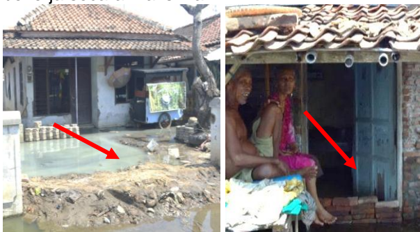
Gambar 5. a. Adaptasi membuat tanggul tipe 1, b. Adaptasi membuat tanggul tipe 2
