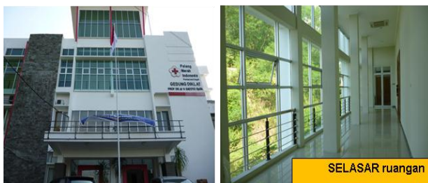
Gambar 4. Existing Gedung Diklat PMI Provinsi Jawa Tengah
