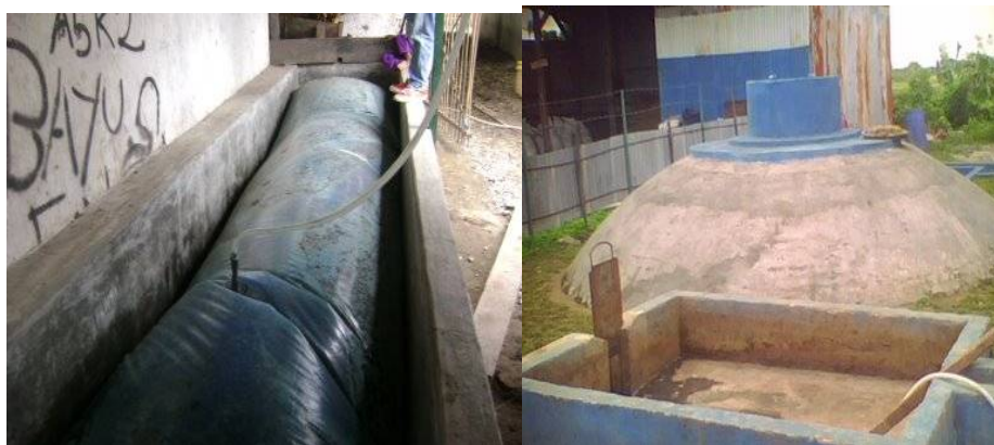
Gambar 1. Contoh konstruksi digester bentuk kubah dan kantong plastik
