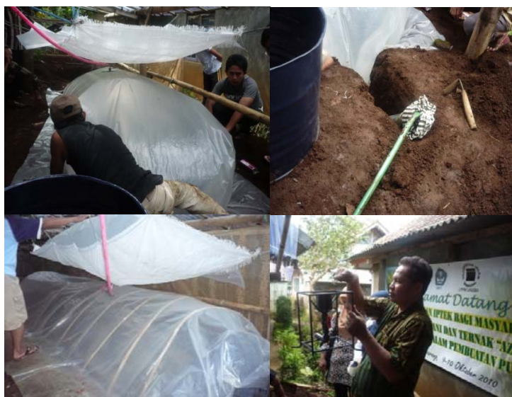
Gambar 2. Perakitan dan instalasi reaktor biogas plastik
