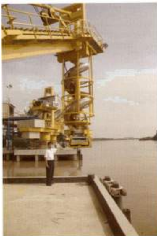
Gambar 8. Sistem konveyor untuk mentransportasikan beras dari pabrik ke kapal tongkang.
