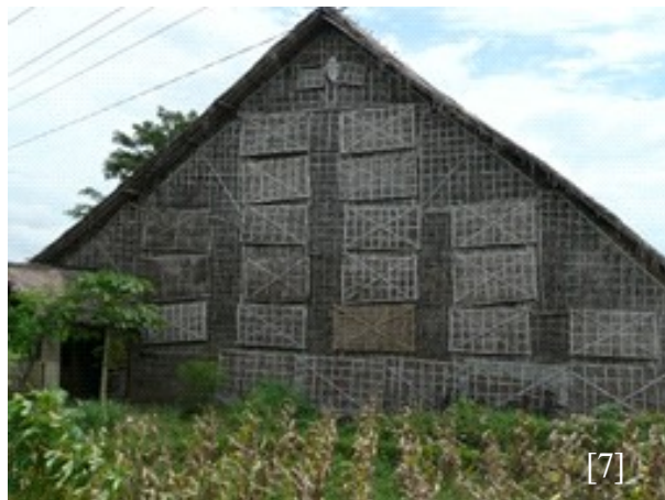
Gambar 7. Bangunan los dengan sudut kemiringan atap 45 derajat sebagai respon atas iklim tropis lembab. Sumber: Dokumentasi Prawoto, 2009.
