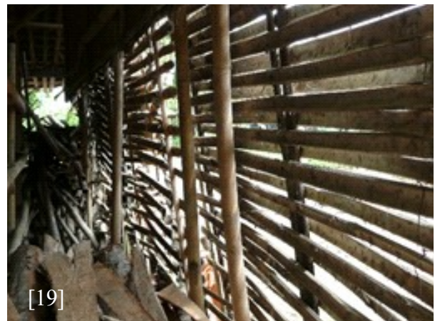
Gambar 18 dan 19. Dinding poreous bernafas pada tobong menggunakan bahan anyaman bambu dan anyaman daun kelapa.. Sumber: Dokumentasi Prawoto, 2009.
