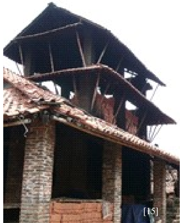
Gambar 14 dan 15. Atap bertingkat dengan teritisan lebar pada Tobong sebagai solusi cerdas ketika proses pembakaran. Sumber: Dokumentasi Prawoto, 2009.
