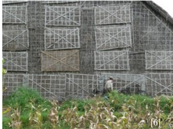
Gambar 5 dan 6. Dinding bernafas pada los dengan banyak bukaan yang bisa dibuka-tutup dengan fleksibel.
