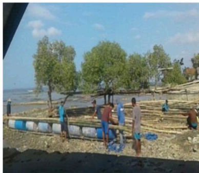
Pemasangan drum/di ikat sama
