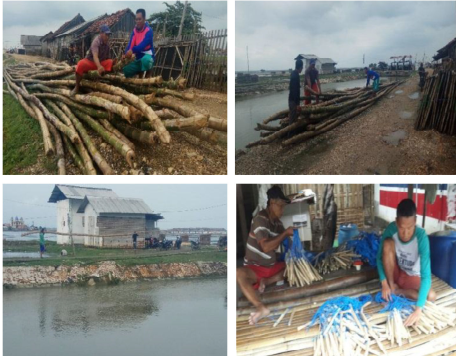
Gambar 8. Tahap Awal Pembuatan Bagan (Pengecekan Bambu Sebagai Bahan Praktek Pembuatan Bagan Membawa Bambu ke Lokasi dan Pembuatan Pengikat Bagan Berbahan Tali dan Bambu)
