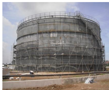
Gambar 1. Kebutuhan scaffold pada pembangunan tangki
