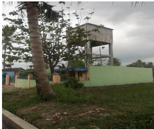
Gambar 13. Lokasi Sumur Air Bersih Dusun Sono Tengah
