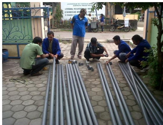
Gambar 9. Pipa-Pipa Pengganti Jaringan Lama
