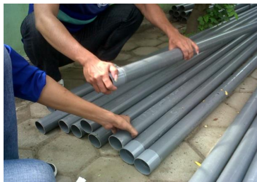
Gambar 2. Pipa Jaringan Utama Pendistribusian Air ke Warga
