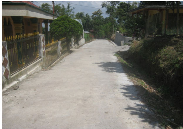
Gambar 2. Cor jalan ikua Gantiang Kapalo Koto sumber: dokumentasi peneliti
