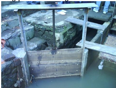
Gambar 3. Memperlihatkan Setelah dipasang Pintu Pengelak atau Pintu air pada PLTMh.
