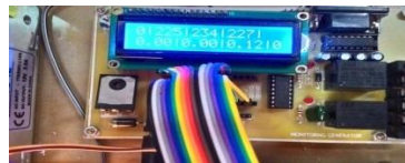
Gambar 3 Pengukuran arus keluaran genset
