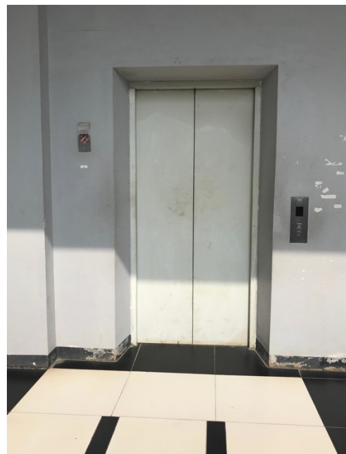
Gambar 5.5. Ruang Lift Gedung Kuliah Umum
