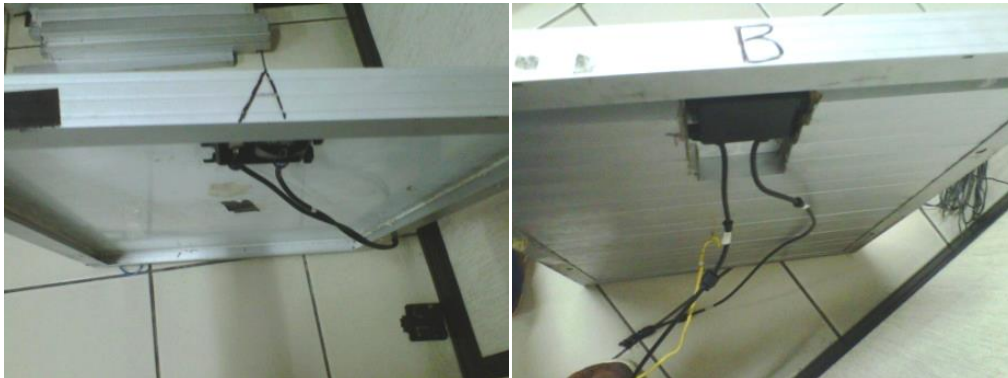
Gambar 4. Pemasangan PCM pada Modul surya.
