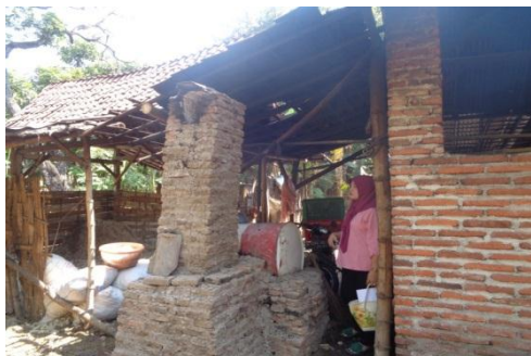
Gambar 2. Pembuatan Cerobong Industri Tahu
