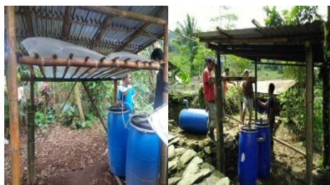
Gambar 3. Praktek pembuatan digester
