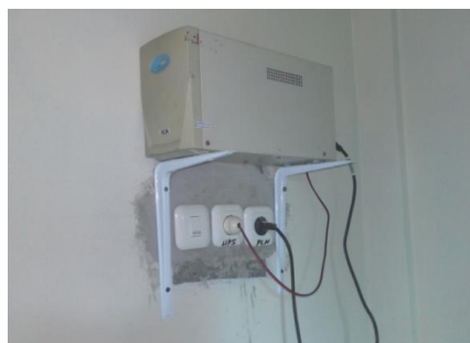
Gambar 12. Dudukan dan Pemasangan UPS
