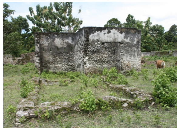
Foto 6. Struktur bangunan yang terdapat di dalam kompleks benteng (Sumber: Dokumen Balar Ambon 2011)
