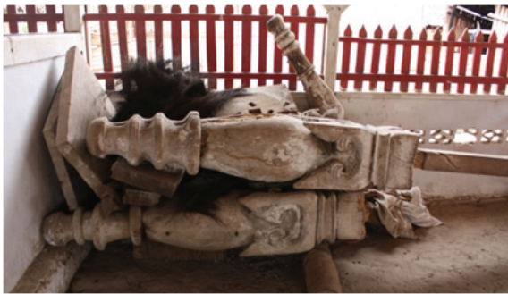
Foto 6. Tiang Alif di Masjid Kuno Rohomoni, terbuat dari kayu Bintanggur yang sudah tidak digunakan lagi.
