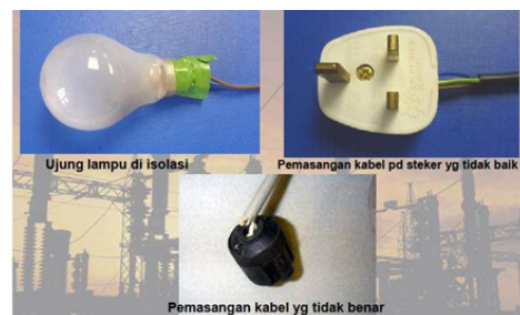
Gambar 4: Potensi tersentuh langsung pada kawat yang bertegangan karena pemasangan kabel yang tidak benar
