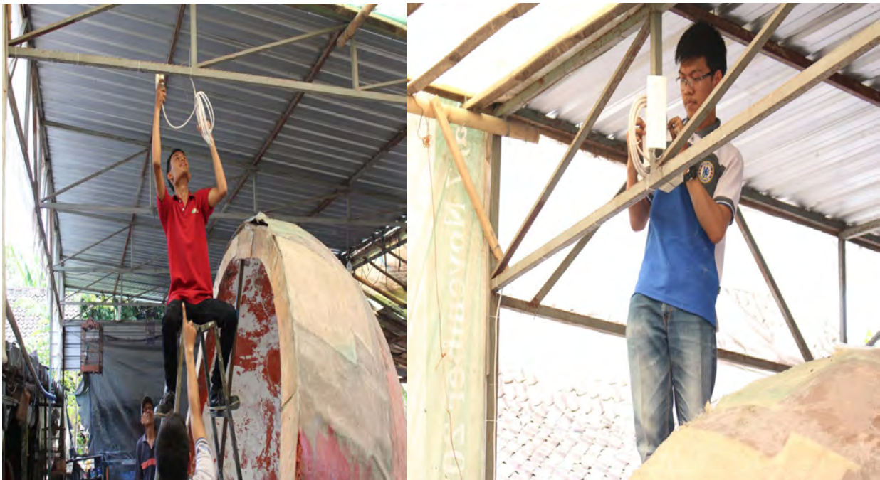
Gambar 6. Proses pemasangan perangkat jaringan internet di UMKM Gali Kreatifitas Fiber
