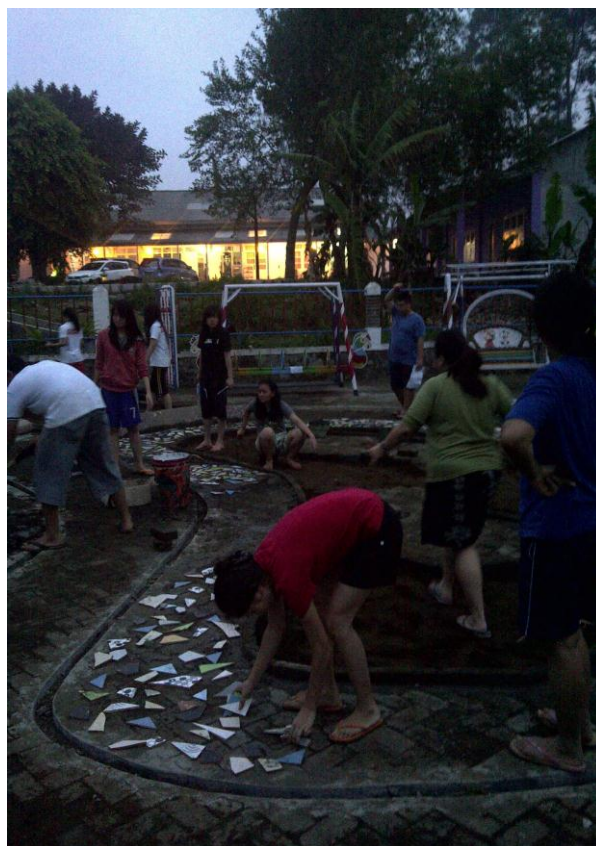
Gambar 5. Pemasangan mozaik di lapangan
