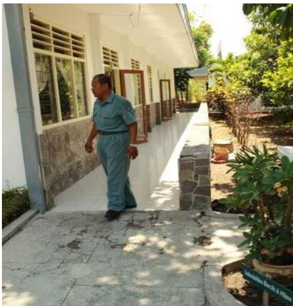
Gambar 6. Selasar yang cukup lebar dan didesain dengan ramp .
