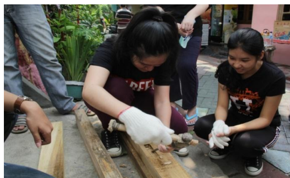
Gambar 8. Proses Pembuatan Coakan Sambungan Kayu
