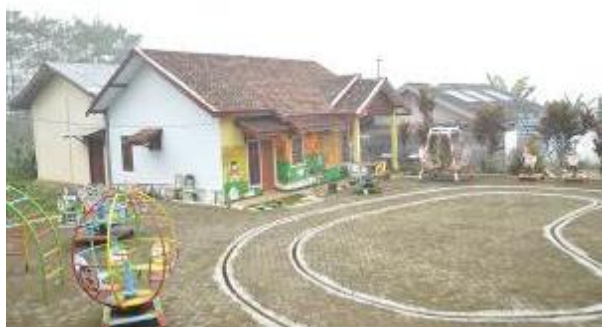
Gambar 1. Kondisi Eksisting PAUD
