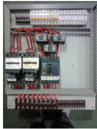
Gambar 32 Pemasangan kabel sesuai penempatan komponen
