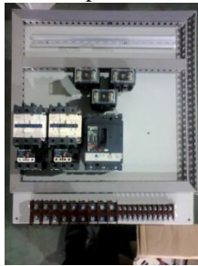
Gambar 28 Penempatan komponen dalam box panel
