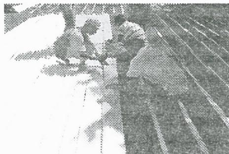
**Gambar 10.** Fabrikasi geomembran di lapangan
