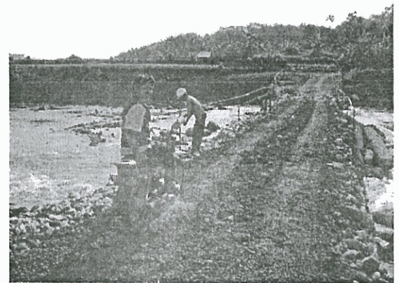
Gambar 10. Pemasangan tiang pembatas di tepi lintasan
