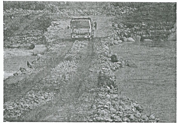
Gambar 8. Lintasan bronjong selesai, terlihat arus deras lewat pipa
