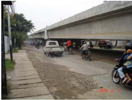
**Gambar 5.** Kerusakan Jalan Akibat Sistem Drainase dan Material Sisa yang Tidak (Masalah Pemeliharaan pada tahap Paska-konstruksi)
