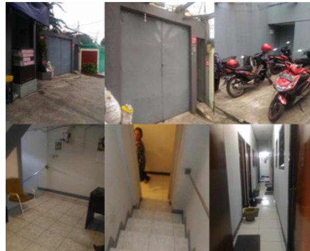
Gambar 1.1 Bangunan Gedung di Jl. Cipaku Permai yang Berada di Bawah Tanah.
