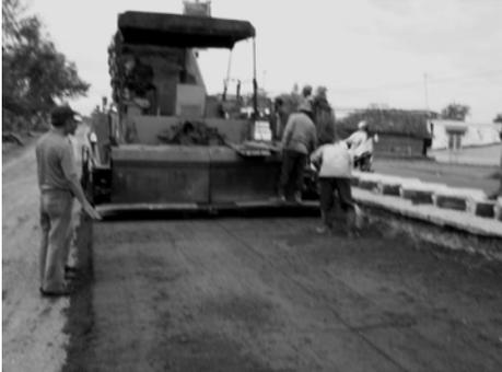
**Gambar 6b.** Paver penghampar campuran dengan *foam bitumen*
