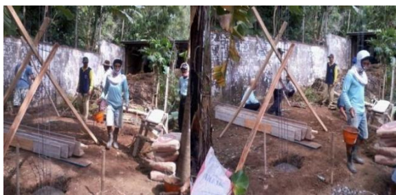
Gambar 2. Proses awal pembangunan rumah kompos
