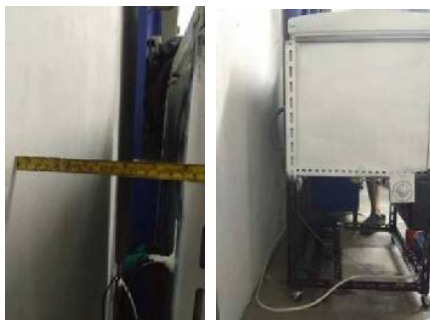
Gambar 14 Gambar contoh jarak mesin show case pendingin sosis dan dinding
