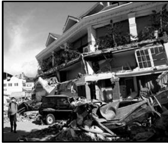
Gambar 1. Bangunan Hotel yang Runtuh Akibat Gempa.
