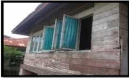
Bangunan ini mengikuti kondisi iklim panas lembab, yaitu dengan memperbanyak bukaan yang lebar. Bukaan pada sisi depan rumah (arah selatan), menggunakan jendela berukuran 50 x 120 cm per jendela, empat lubang jendela berukuran 240 x 170 cm dengan jumlah 10 daun kaca nako. Lubang angin dibuat memanjang mengikuti ukuran jendela sehingga sirkulasi udara tetap lancar meskipun jendela tertutup.
