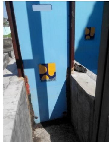
**Gambar 7** Pintu Air GFRP di Laboratorium Hidrolika Balai Irigasi
