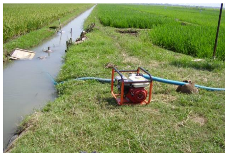
Gambar 6 Pemompaan Air dari Saluran Tersier
