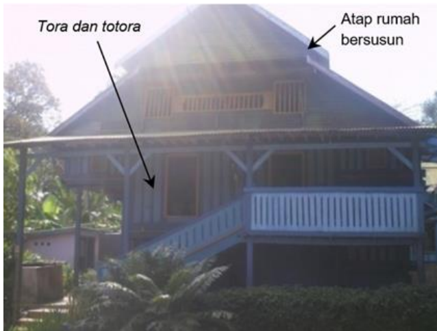
Gambar 5. Facade rumah kaum Walaka yang memiliki jabatan (sumber: Umar, 2012)
