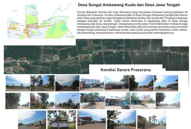
Gambar 2. Kondisi fisik bangunan di koridor Ambawang pada desa Sungai Ambawang dan desa Jawa Tengah (sumber analisis, 2017).
