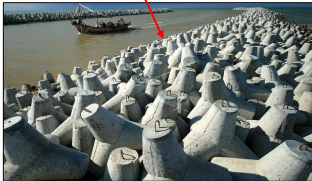
Gambar 6. Bangunan pemecah gelombang tsunami
