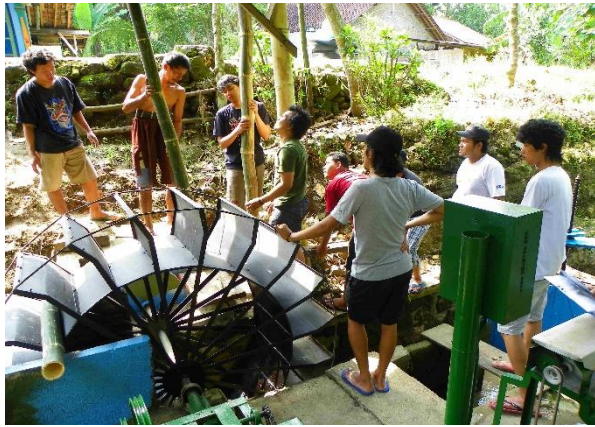
Gambar 9 Pelaksanaan perbaikan pembangkit Mikrohidro
