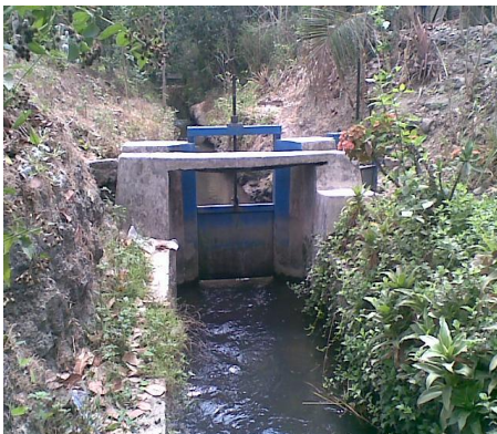
Gambar 6. Pintu irigasi Utama pada PLTMh
