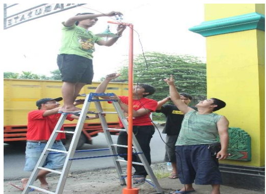
Gambar 13. Pemasangan lampu penerangan jalan bersama masyarakat
