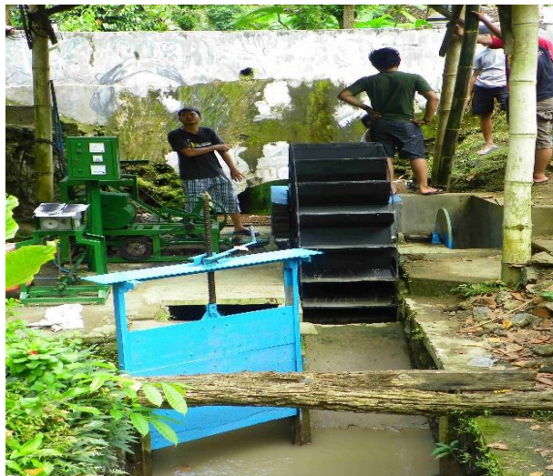
Gambar 8 Penempatan pembangkit Mikrohidro
