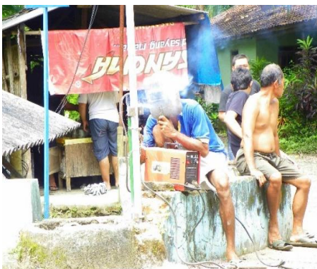
Gambar 12. Pemasangan lampu penerangan jalan bersama masyarakat
