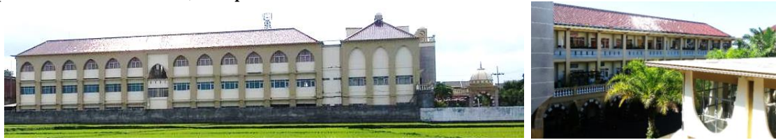
Gambar 3. Tampak Sisi Tenggara dan Barat Laut SMP Islam Sabilillah Malang.
