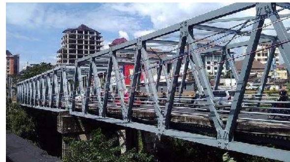
Gambar 3.1 Jembatan rangka Soekarno-Hatta, Malang
