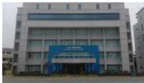
Gambar 2. Gedung Laboratorium Terpadu Universitas PGRI Palembang
