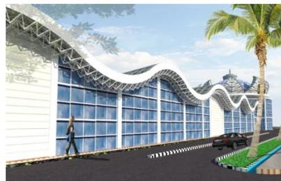
Gambar 6. Detail *Space Frame* pada fasad bagian selatan Malang Convention Center
