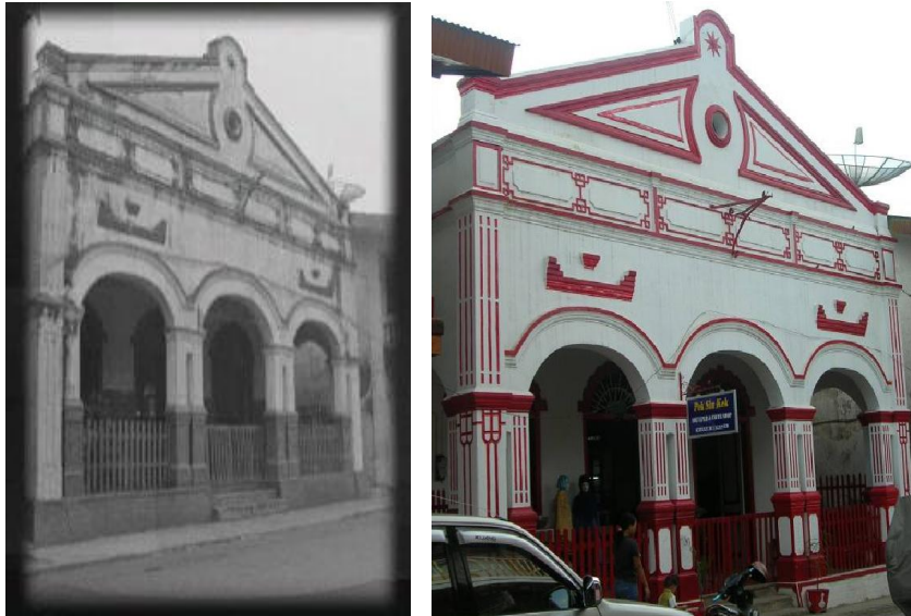
Gambar 5. Fak Sin Kek Sebelum dan Sesudah Pemugaran sebagai Upaya Peningkatan Kualitas Lingkungan dalam Rangka Mewujudkan Visi “Kota Wisata Tambang yang Berbudaya”
