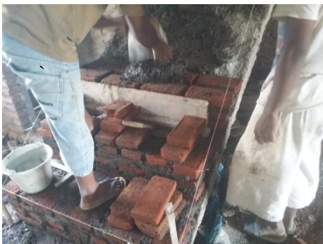
Gambar 2. Perataan Luluhan Sebelum Pemasangan Bata Tangga
