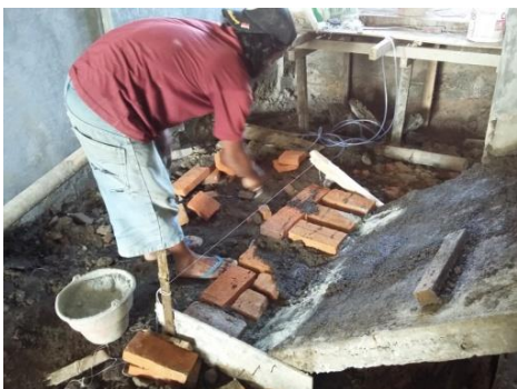
Gambar 3. Pemasangan Bata Tangga Oleh Tukang
