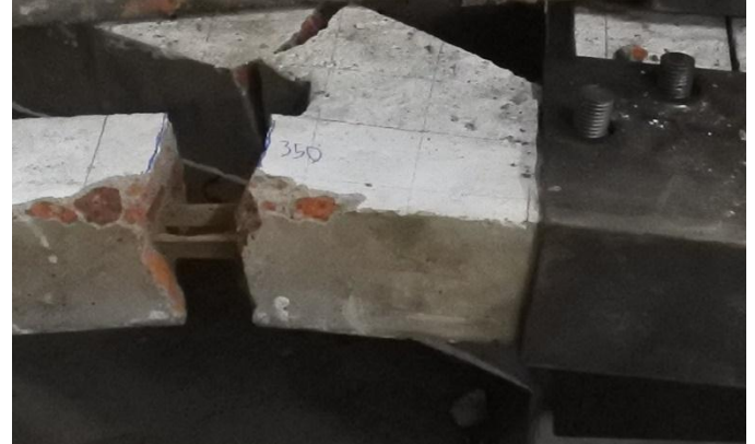
Gambar 14. Kondisi terakhir retakan pada kuda-kuda Tipe A
